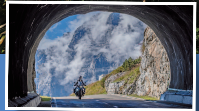
Tunnelblick in den Dolomiten
